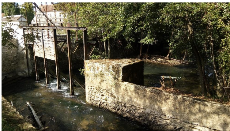
Vannage et déversoir
