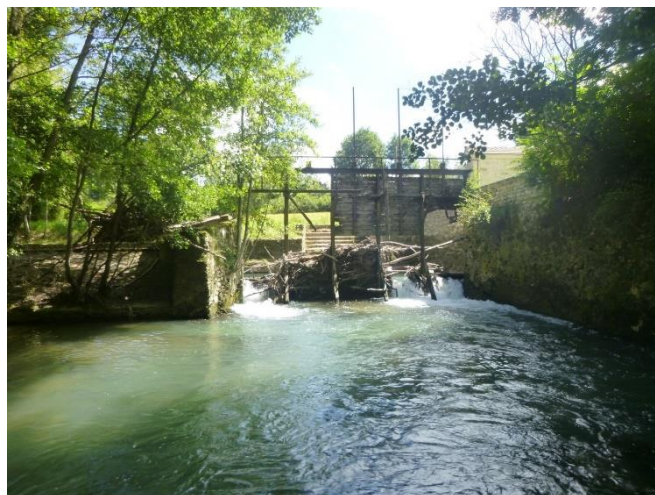
Figure 37 : Moulin de Court pendant la campagne de mesure de débits
